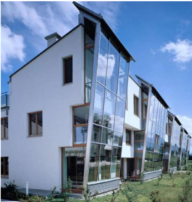
Un esempio di facciate con serre solari captanti e tampone. Villette residenziali passive, Complesso Gneis Moos, Salisburgo, Austria Arch. Georg W. Reinberg
